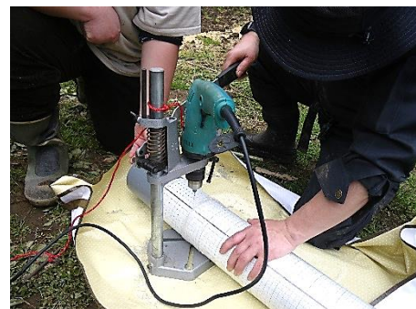
15mm 間隔で取水穴を開ける作業
