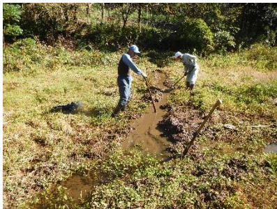
写真13 土水路の新設
