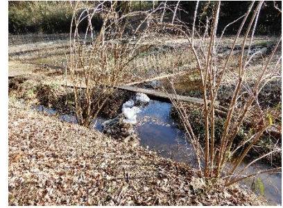
写真15 新設した堰(上の田)
