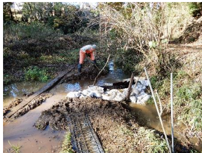
写真14 堰の新設(上の田)
